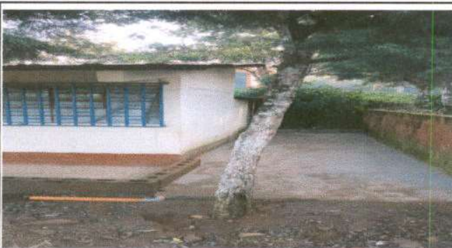
Foto 3: Sustitución de Piso de torta de concreto 20m2
