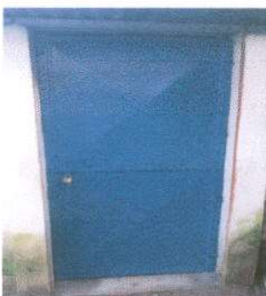
Foto 5: Sustitución de puerta
