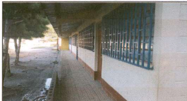
Foto 2: Sustitución de balcones de metal 25 M2
